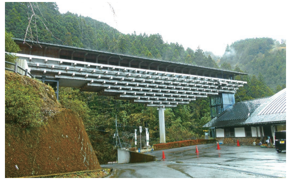
「雲の上のギャラリー」1本(何本か集成している)の柱でささえている。
