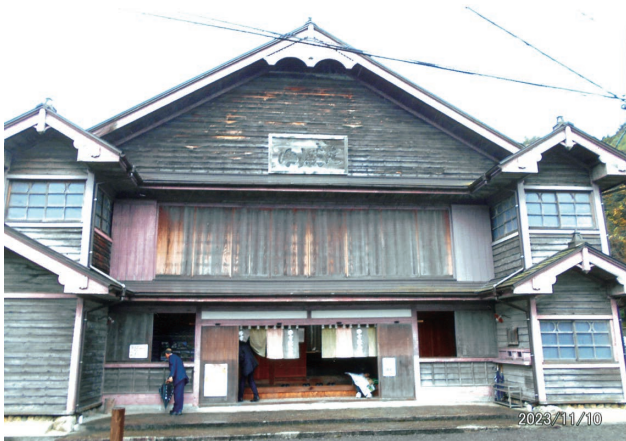
「ゆすはら座」の正面から。修復移転してから30年近くなので外装はかなり古く見える。
