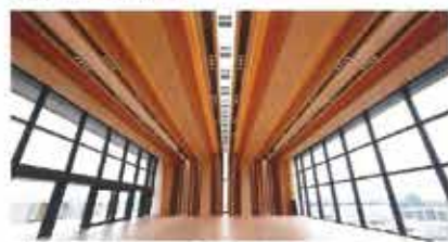
輪の架構で屋根を支えた木構造で両サイド ガラス張りのホール
