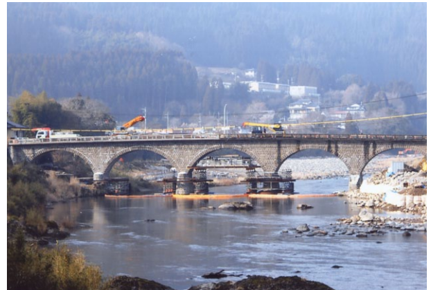
※橋No.5、馬溪橋、5連の橋で文化財に指定されており、平成24年7月の大水害で被害を受け暫定的な措置として平成26年6月に通行が再開している。(現在、一部工事中。)
