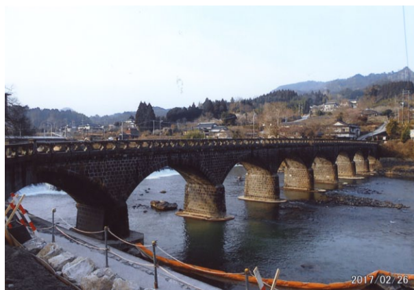
※橋No.11 耶馬溪橋、別名オランダ橋とも言われ、日本唯一の8連アーチ石造橋で橋長116m、大正時代に架設された、大変めずらしい石橋である。平成24年7月に豪雨で一部破損したが、復旧工事が完了し、開通している。（現在、一部工事中。）
