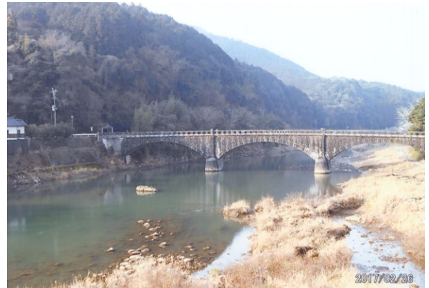
※No.8の羅漢寺橋、石造3連アーチ橋、青の洞門の上流にある。
