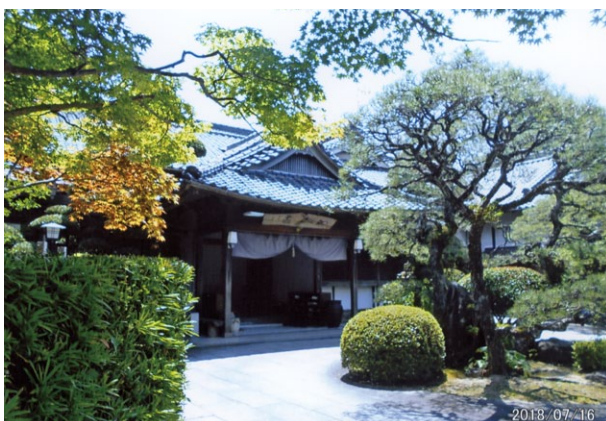
※木造平屋の玄関で築80年になる
