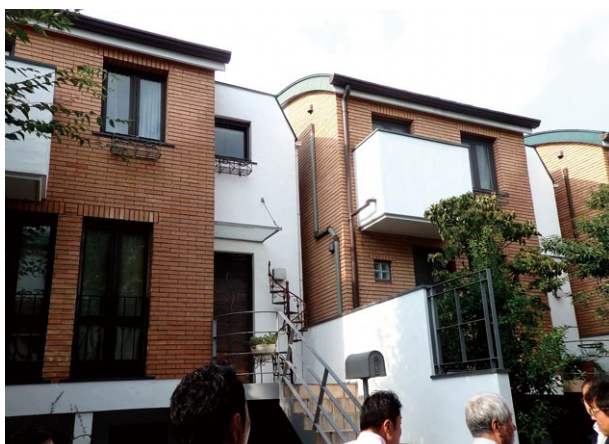
実際の施工物件の見学 竣工30年の現在も美観が保たれている
