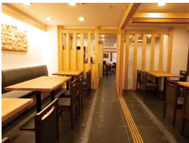
プレカット加工した柱や梁
