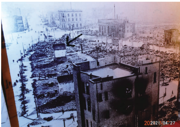
関東大震災後の浅草の焼け跡。手前のビルがデンキプランで有名なビルで奥の小さな建物が「土蔵」の竹屋である
