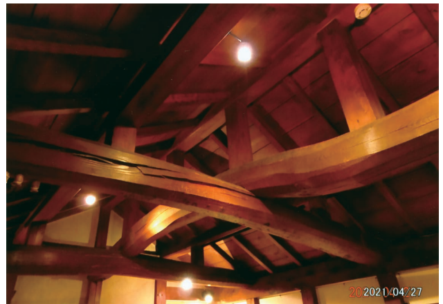
「土蔵」の内部天井、木組みの様子
